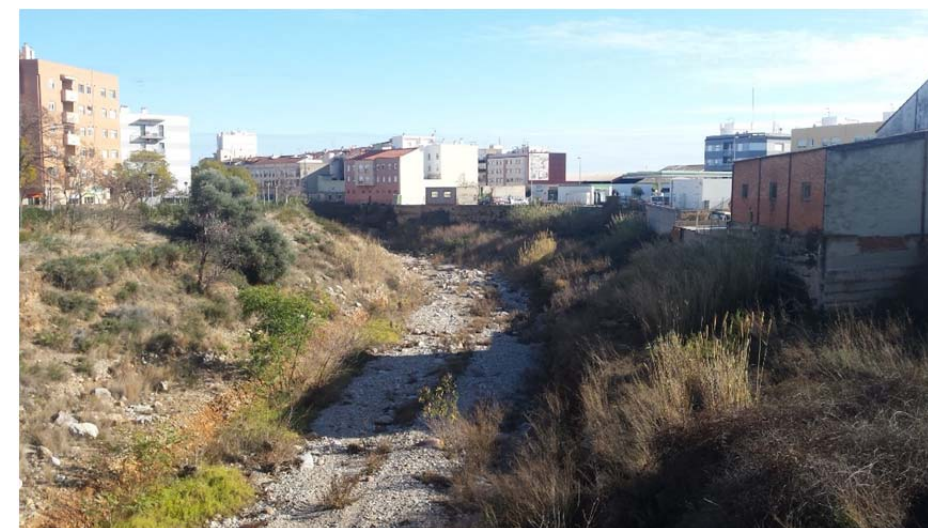
Figura 2: Cauce del Riu Sec desde el puente de la Universitat
